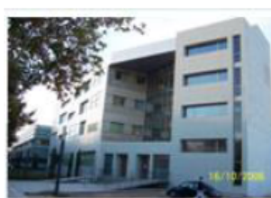
EDIFICIO MARIE CURIE
