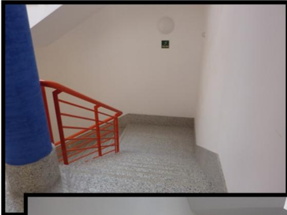
**E1:** Escalera interior protegida situada en ala derecha del edificio que ofrece un ancho de paso de más desfavorable de 1,62m y que ofrece una evacuación descendente desde la 2ª planta hasta la planta baja, donde se produce la salida a calle y ascendente desde el sótano.
