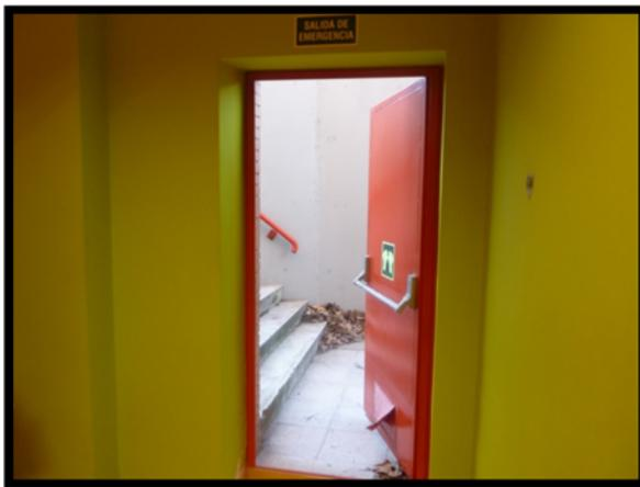
**A8/SE6:** Salida a calle desde planta sótano (gimnasio) a través de puerta RF que ofrece un ancho de paso de 0,85m
