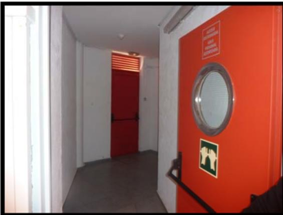
**A5/SE4:** Salida a calle desde planta sótano a través de puerta RF (gimnasio) que ofrece un ancho de paso de 0,85m. Debe considerarse INADECUADA puesto que se encuentra cerrada con llave
