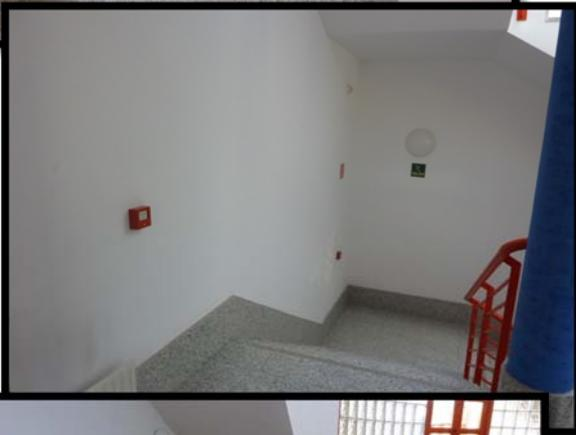
**E2:** Escalera interior protegida situada en ala izquierda del edificio que ofrece un ancho de paso de más desfavorable de 1,50m y que ofrece una evacuación descendente desde la 2ª planta hasta la planta baja, donde se produce la salida a calle y ascendente desde el sótano.
