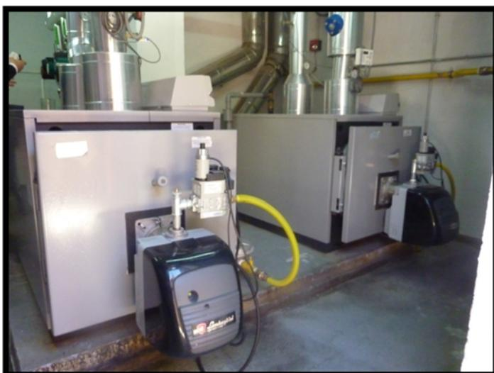
El cuarto de calderas se encuentra ubicado en el sótano del edificio. La canalización de la tubería es soterrada hacia el exterior del mismo.
