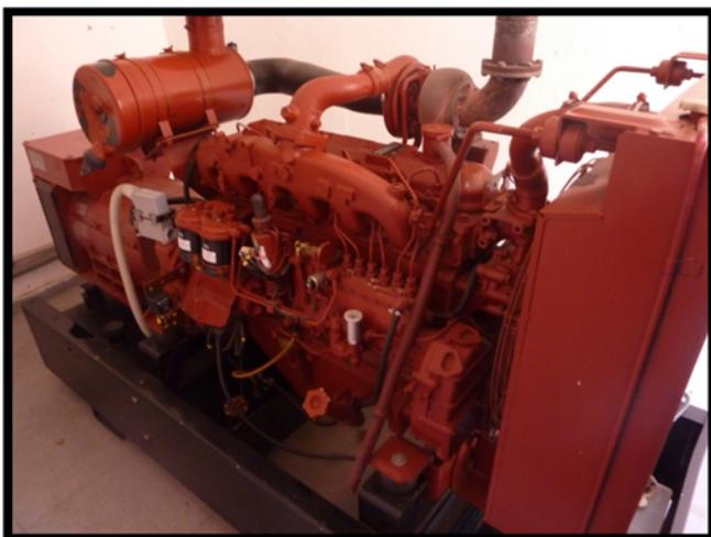
El grupo Electrógeno asegura el suministro de reserva del edificio en caso de fallo del suministro de red. Se encuentra ubicado en el sótano del edificio en un local compartimentado.
