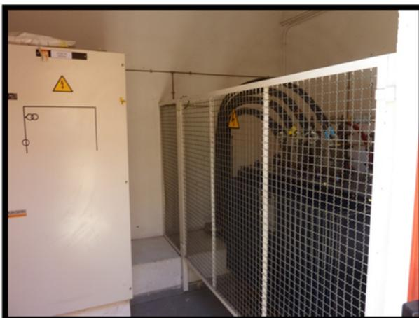
El suministro de energía eléctrica se realiza en alta tensión por parte de la compañía suministradora hasta el Centro de Transformación situado en un local propio e independiente en la zona de instalaciones de la planta. El Centro de Transformación dispone de las correspondientes celdas de protección, medida y seccionamiento.
