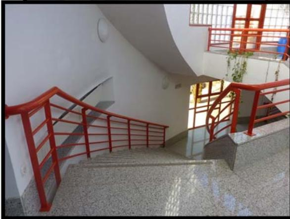
**E3:** Escalera principal del edificio interior y no protegida que se sitúa en su eje central y que se constituye por brazos o tramos independientes. Ofrece un ancho de paso más desfavorable de 1,63m y una evacuación descendente desde la segunda planta a la planta baja.
